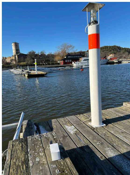
Glödlampsbyte den 16 februari 2025. Fyrkaraktären är OC (3) 20 sekunder
